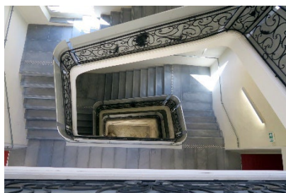
L'escalier central de l'Hôtel Lagarrigue
